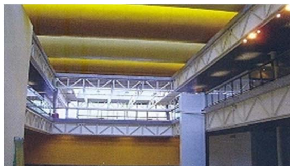
b) Edifício Sede V&M – Belo Horizonte – ligações RHS/CHS
