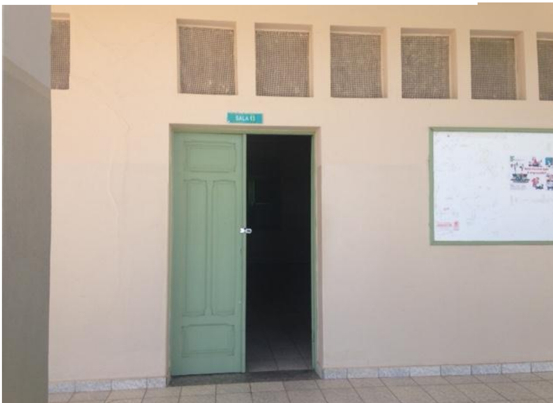
Figura 1: Fachada da sala destinada à implantação do LAEQ
