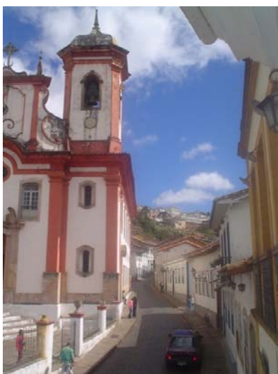
Foto 6: A grande proximidade entre a Igreja Matriz de N. S. da Conceição e as edificações da praça Antônio Dias e da rua Bernardo de Vasconcelos.
