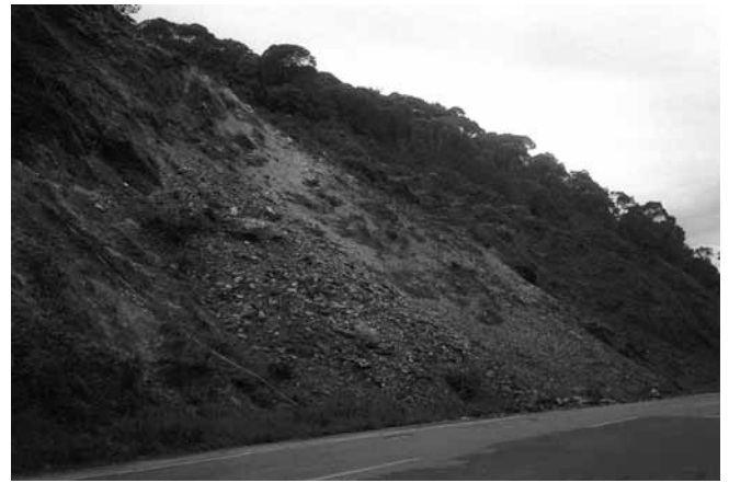
Figura 10 - Área estudada mostrando a o depósito de tálus oriundo de rupturas no talude.
