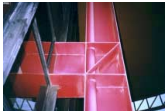
Figura 28 - Ligação rígida
