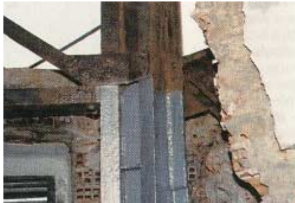
Figura 11 - Recuperação de coluna deteriorada por corrosão – SANTOS 62
