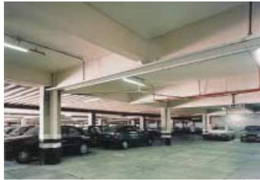
Figura 73 - Estrutura metálica com laje maciça
