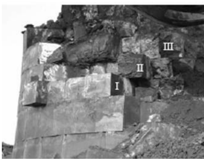
Figura 3.26 – Vista do estado de desgaste da parede do cadinho, FRASER e outros.(2004)
