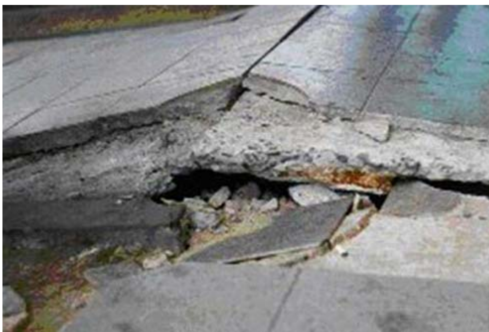
Figura 3.7 - Erupções em uma estrada causada pelo fenômeno da expansibilidade da escória de aciaria (VILELA, 2006).
