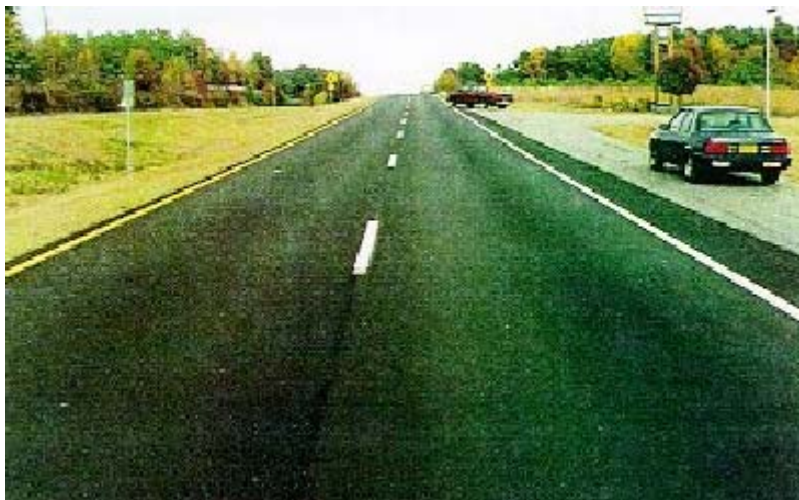
Figura 3.14 - Utilização do resíduo de granito em mistura asfáltica (SOUZA et al., 2003).
