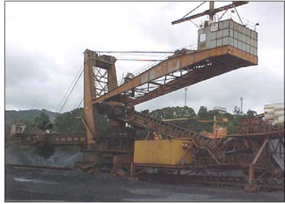
(b) Recuperadora Tambor ( Drum )
