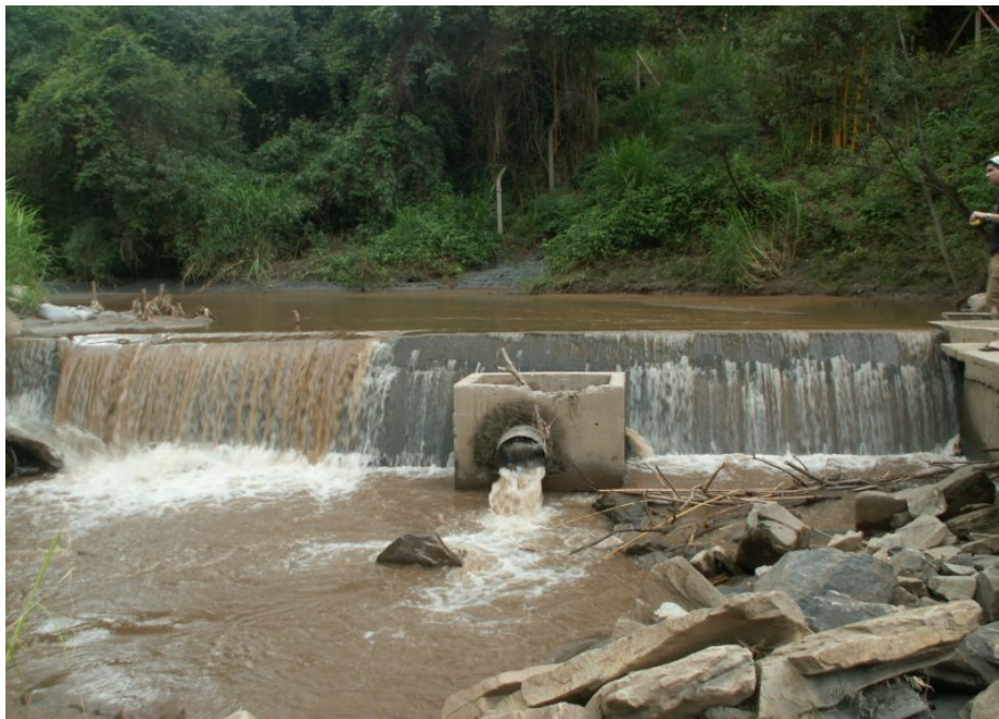
Figura 4.4 Captação feita na ETA Funil.
