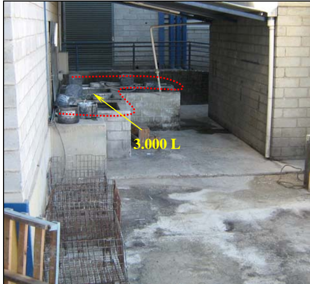
Figura 4.5. Estação de Tratamento de Efluentes Industriais “depois” da implementação da oportunidade de P+L
