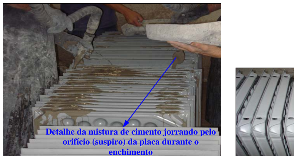
Figura 3.20. Etapa de enchimento das placas do piso elevado (detalhe dos dois furos por placa na imagem menor)
