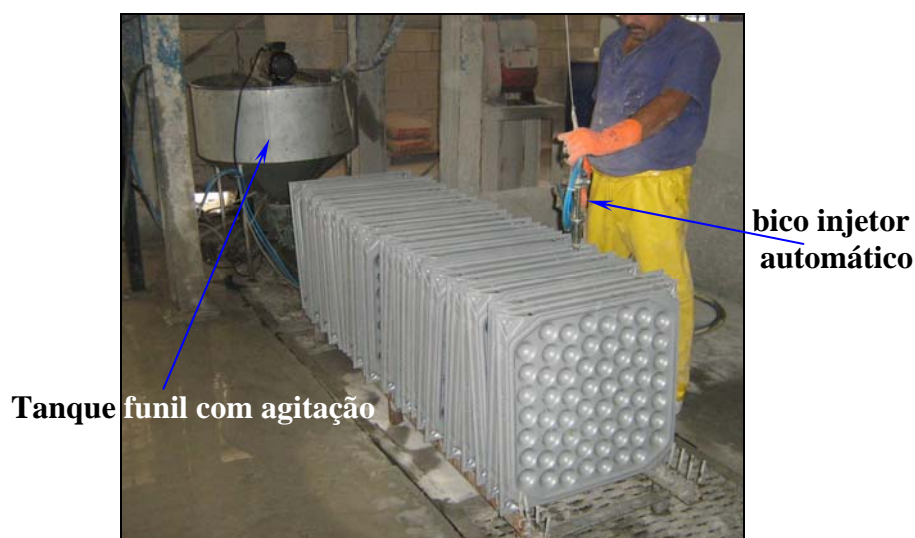
Figura 4.7. Equipamento dosador de cimento em funcionamento
