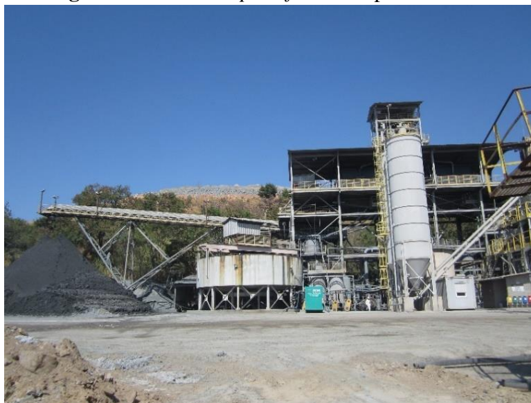
Figura 19: Planta de pastefill - Complexo Turmalina.
