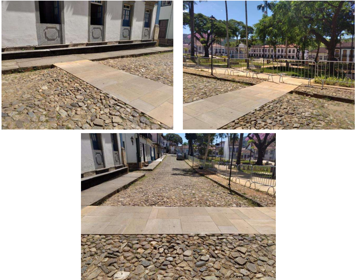
Figura 10 - Rampa de acesso à Praça Gomes Freire atualmente vista em três ângulos distintos
