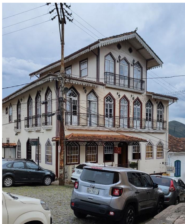
Figura 39 - Rua Costa Sena nº 307, Centro
