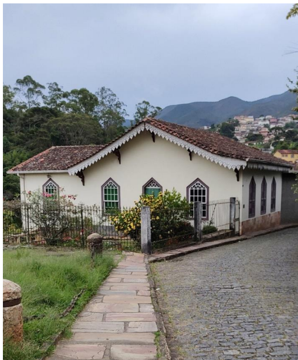
Figura 3 - Chalé Particular, Rua Zizinha Cruz nº 88, Bairro Rosário
