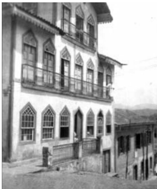
Figura 38 - Rua Costa Sena nº 307, Centro Antigo
