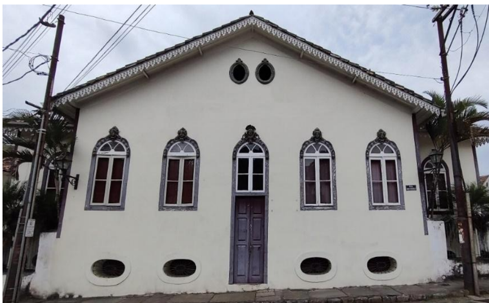
Figura 44 - Rua Diogo de Vasconcelos nº 30 - Pilar
