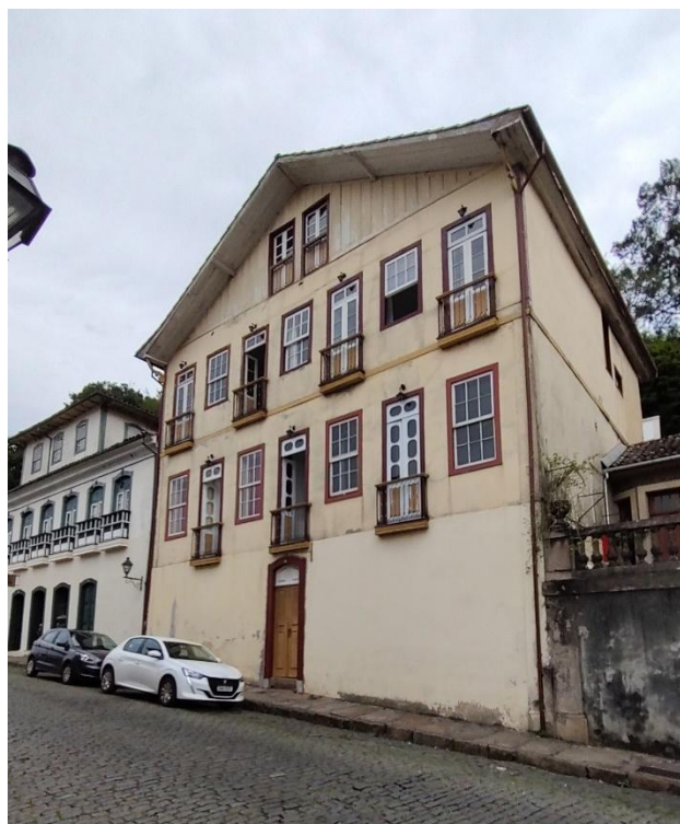
Figura 41 - Rua Getúlio Vargas nº 10, Centro
