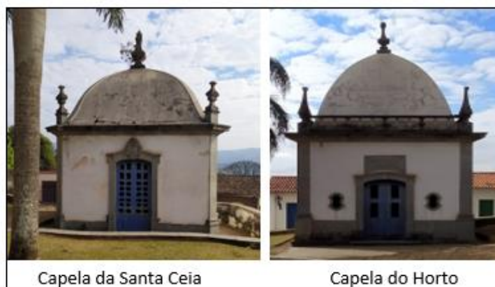
Figura 8: Abóbadas Parabólicas das Capelas dos Passos, de Congonhas, Minas Gerais
