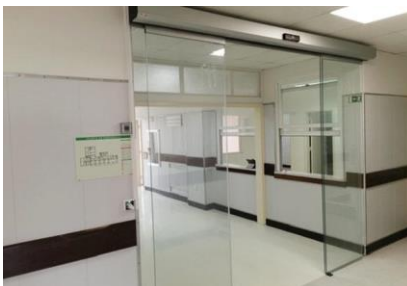
Figura 27: Portas automáticas de um hospital.
