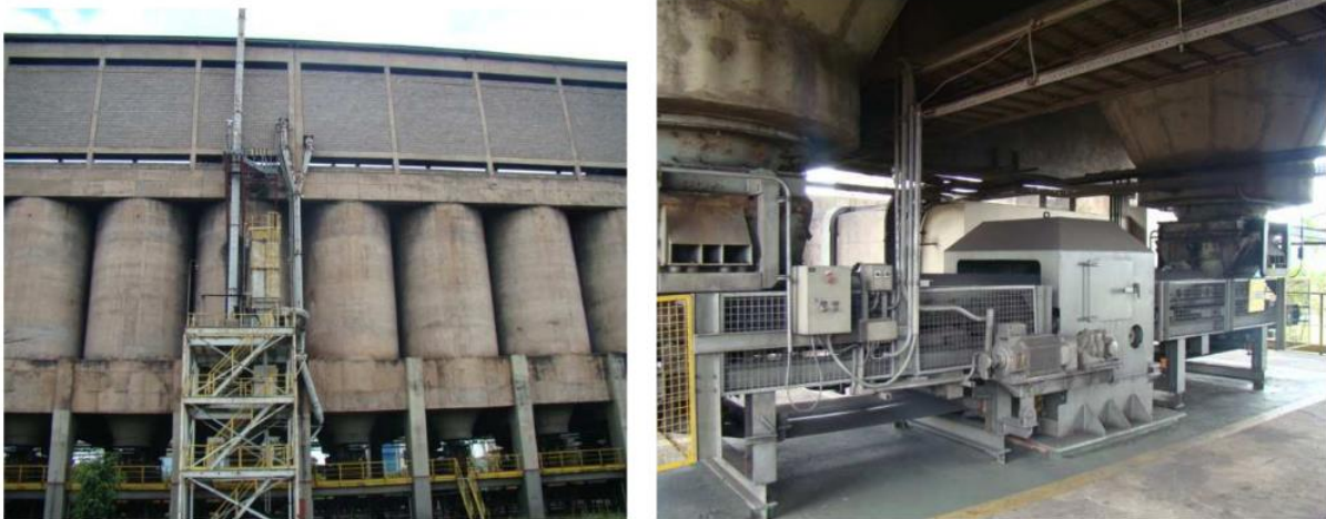
Figura 3.8: Vista da Blending House e o sistema de dosagem das misturas de carvão (Gerdau).
