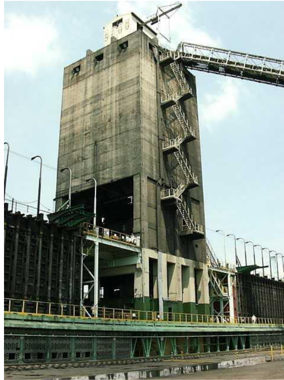
Figura 3.9: Vista do Coal Bunker (GerdaU Usina Ouro Branco)
