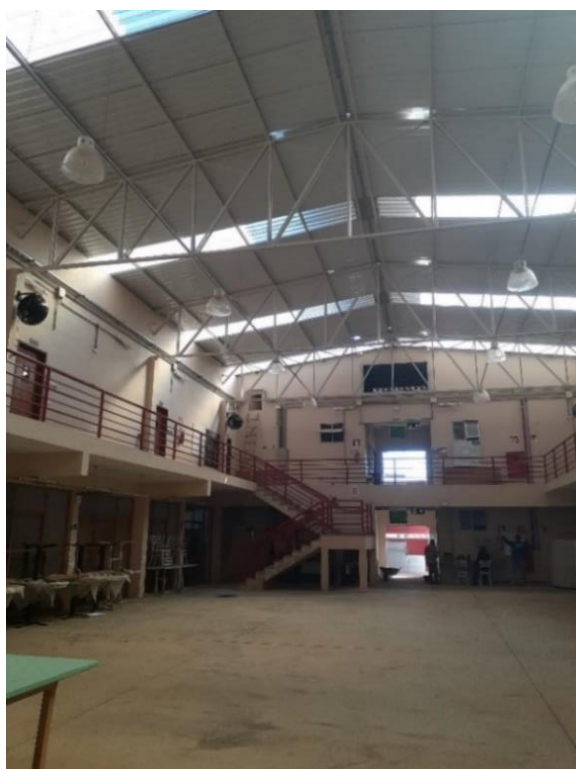
Figura 22 - Vista geral átrio interno
