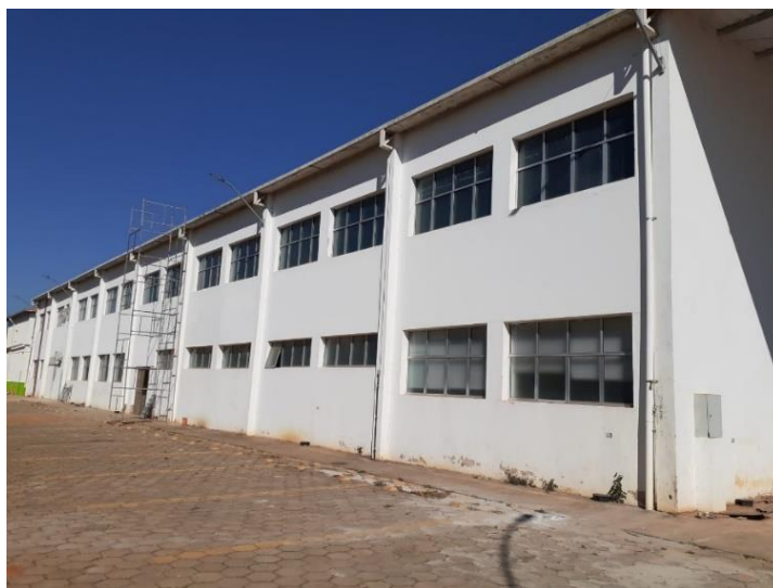
Figura 19 – Fachada frontal prédio Engenharia Civil IFSULDEMINAS
