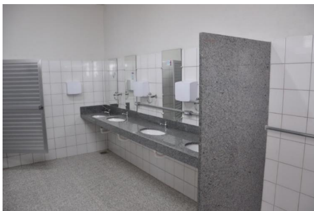
Figura 15 – Sanitário do Restaurante IFMG
