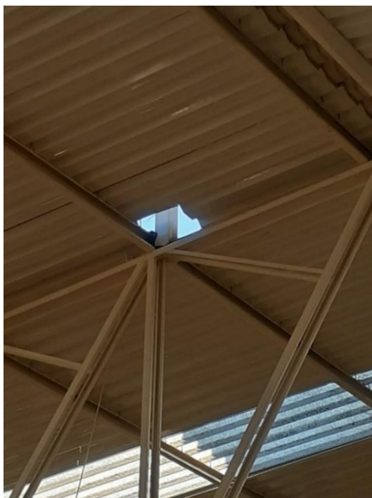
Figura 24 – Detalhe reforma da cobertura
