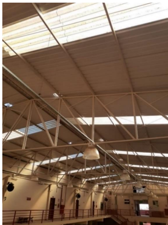
Figura 23 - Vista geral cobertura
