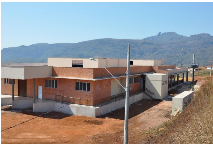
Figura 14 – Fachada posterior e lateral do Restaurante IFMG
