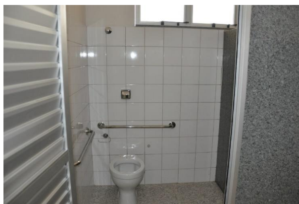
Figura 16 – Sanitário PNE do Restaurante IFMG
