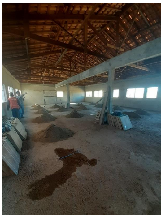
Figura 20 - Vista segunda etapa da obra
