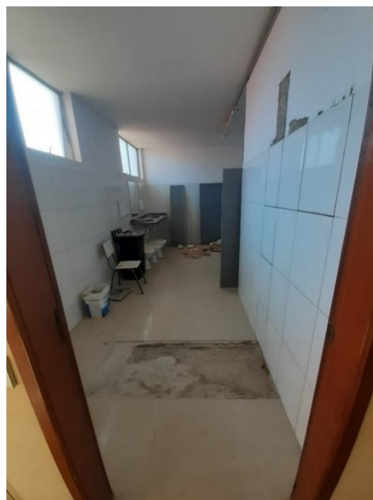
Figura 25 - Vista reforma de sanitários
