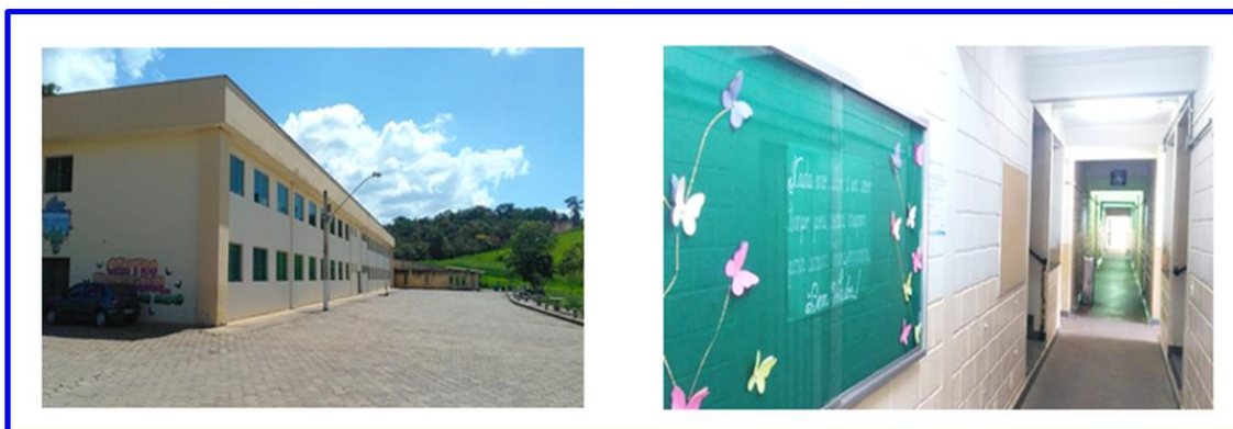
Figura 25 – Estrutura predial externa e interna da escola CESGRA
