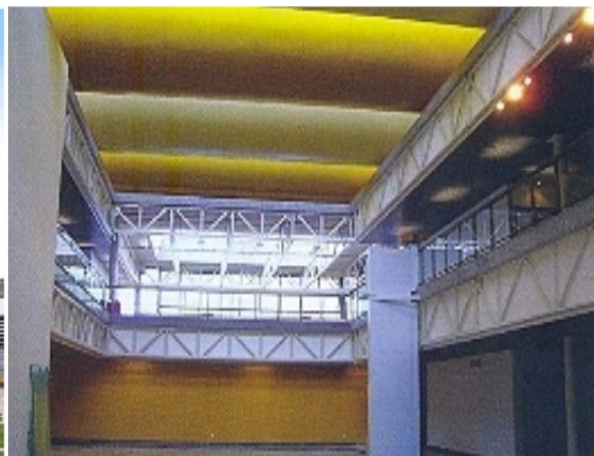
b) Edifício Sede V&M – Belo Horizonte – ligações RHS/CHS
