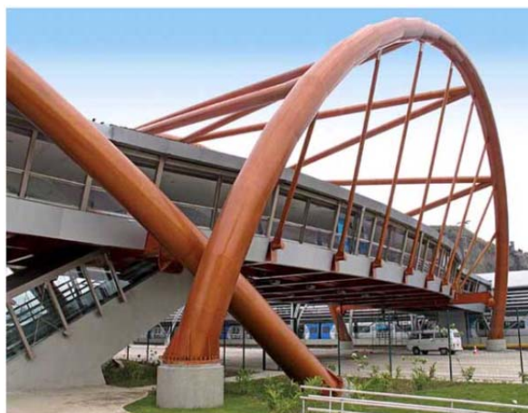
a) Passarela – Rio de Janeiro – ligações CHS
