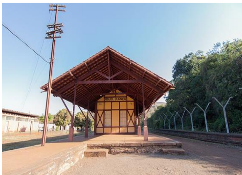
Figura 11- Estação Ferroviária de Miguel Burnier, Ouro Preto/MG.
