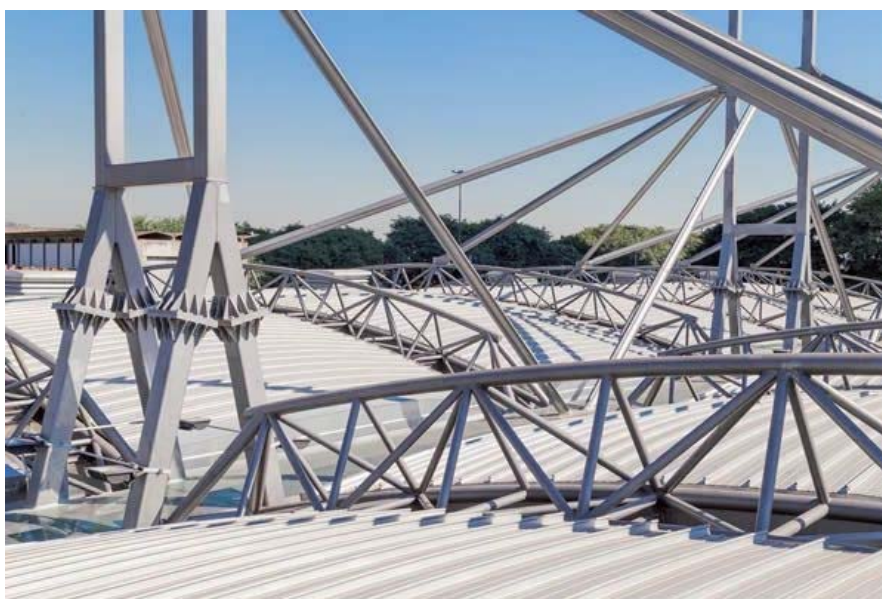
Figura 1 - Estrutura tubular da cobertura do terminal intermodal do Largo da Batata, São Paulo. Fonte: Disponível em < http://infraestruturaurbana.pini.com >. Acesso em: 2 abr. 2016.
