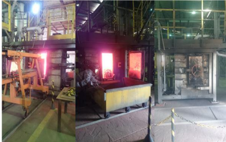
Figura 4.14: Forno piloto da coqueria da Gerdau Ouro Branco (documento interno da Gerdau Ouro Branco, 2015).
