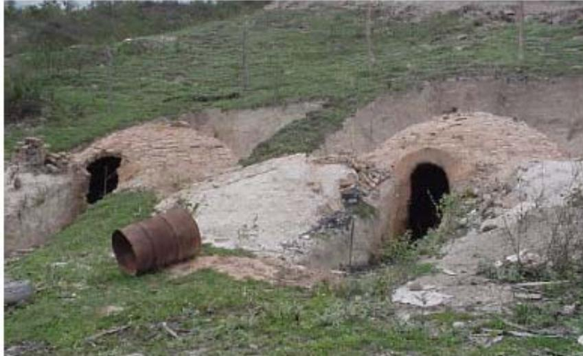
**Figura 3.10: Forno tipo Encosta<sup>[32]</sup>.**
