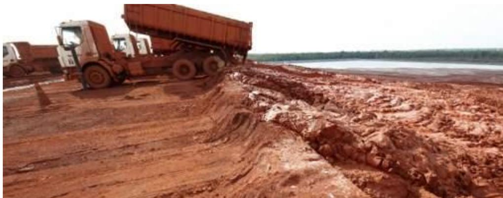
Figura 2.14 – Disposição de lama vermelha da Alunorte, (Barcarena – PA). Rejeito filtrado por filtro tambor
