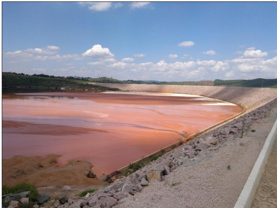
Figura 5.1 – Vista do talude de montante da barragem principal (Foto CBA, 2013)
