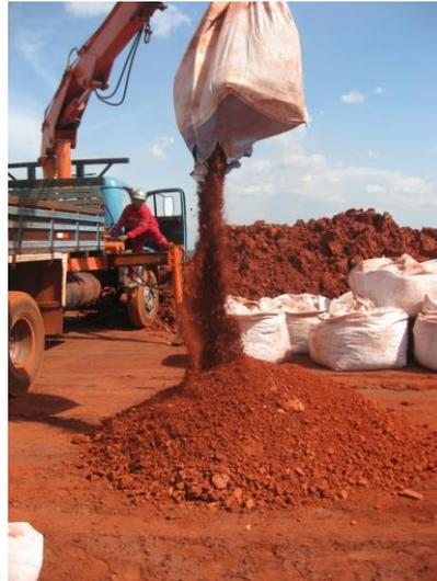
Figura 4.5 – Simulação da formação da pilha teste de resíduo filtrado da Alunorte
