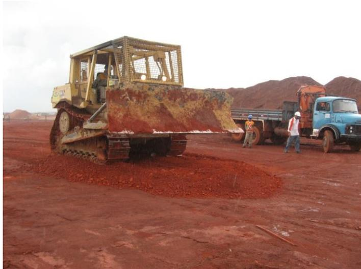
Figura 4.9 – Vista do processo de espalhamento/compactação – Etapa 1
