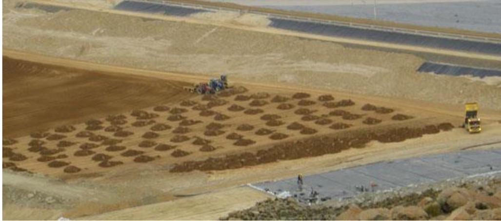
Figura 2.31 – Empilhamento a seco de rejeitos usando o transporte de caminhão. (Fonte: <http://www.tailings.info>)
