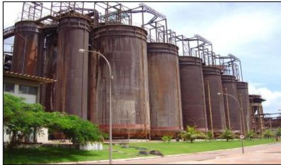
Figura 2.7 – Precipitadores de hidrato de alumínio (Fonte: Souza, 2010)
