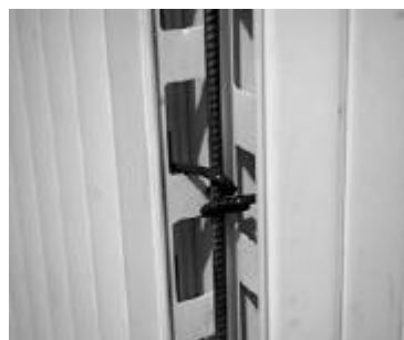
Figura 3.16 – Estrutura de ancoragem entre paredes.
