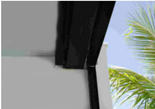
(a) Viga engastada estrutura da casa
