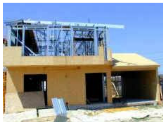
(b) Fechamento de residência em OSB
