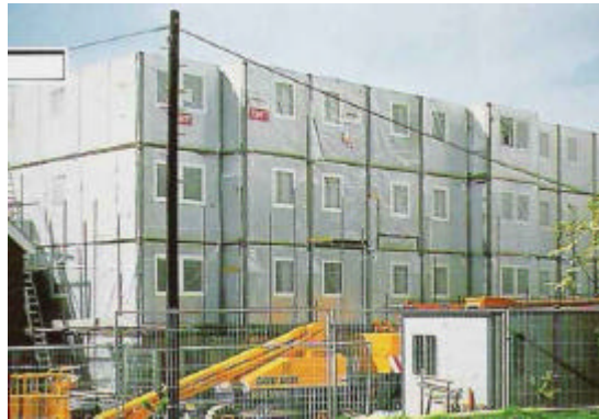
Figura 3.6 – Composição de módulos: residência estudantil, Reino Unido. FONTE : IISI, 1996
