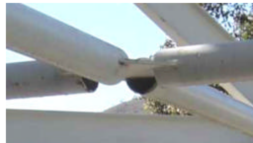
(b) Det. nó contraventamento horizontal
