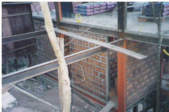
Figura 4.11 –Paredes e divisórias executadas em alvenaria de tijolos cerâmicos. FONTE: Arquivo do construtor
