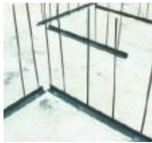
(b) Ancoragem dos painéis com o piso
