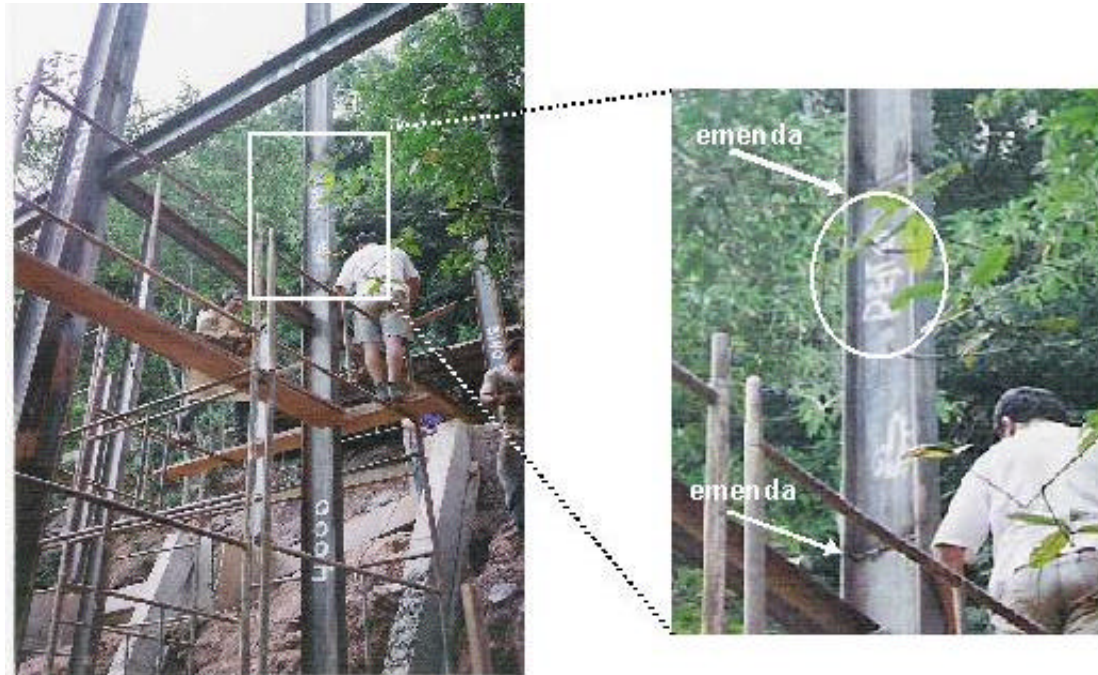
(a) Pilar formado por emenda de peças menores (b) Detalhe das emendas do elemento Figura 4.15 – Visualização dos elementos em situação de montagem da estrutura FONTE: Arquivo do construtor
