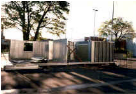
(a) Montagem dos painéis estruturais
