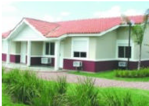
Figura 3.18 – Vista externa da edificação. FONTE: Disponível em: < http://www.casafortemedabil.com.br > Acesso em jan. 2004.
