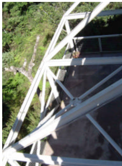
Figura 4.17 – Contraventamento horizontal acrescido. FONTE: Arquivo do construtor
