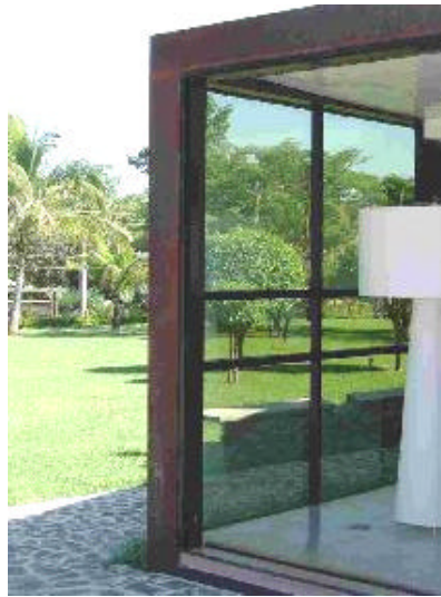
Figura 4.56– Detalhe acabamento da estrutura em chapa de aço patinável. FONTE: Arquivo pessoal.
