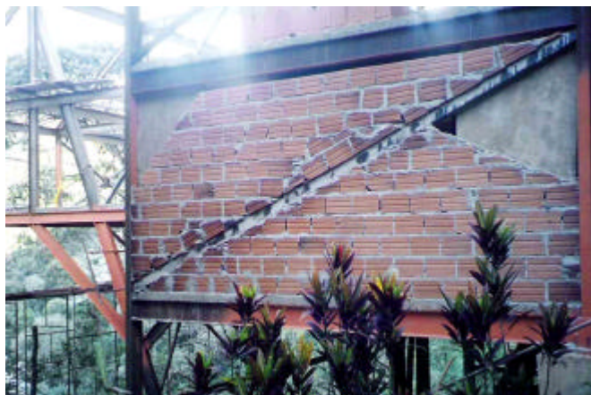
Figura 4.23 – Detalhe execução do fechamento em alvenaria. FONTE: Arquivo do construtor
