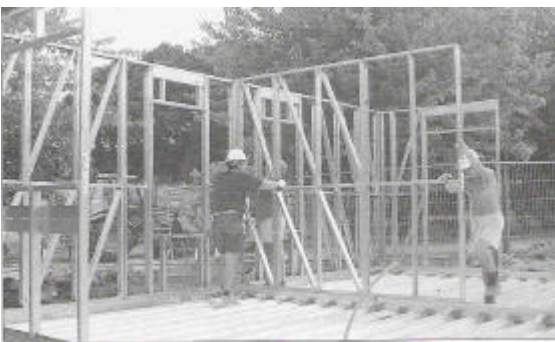
(b) Estrutura em painéis pré-fabricados
