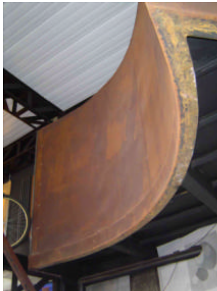
(a) Vista externa do volume do banheiro da suíte
