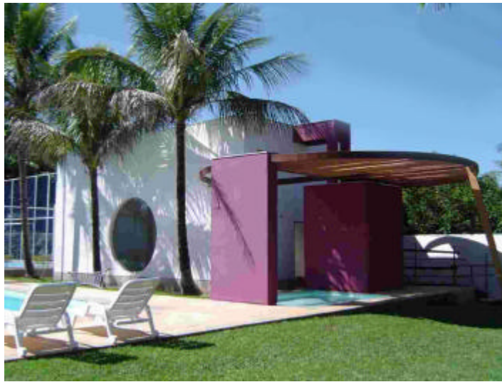
Figura 4.50– Vista quadra de squash contígua à piscina. FONTE: Arquivo pessoal.
