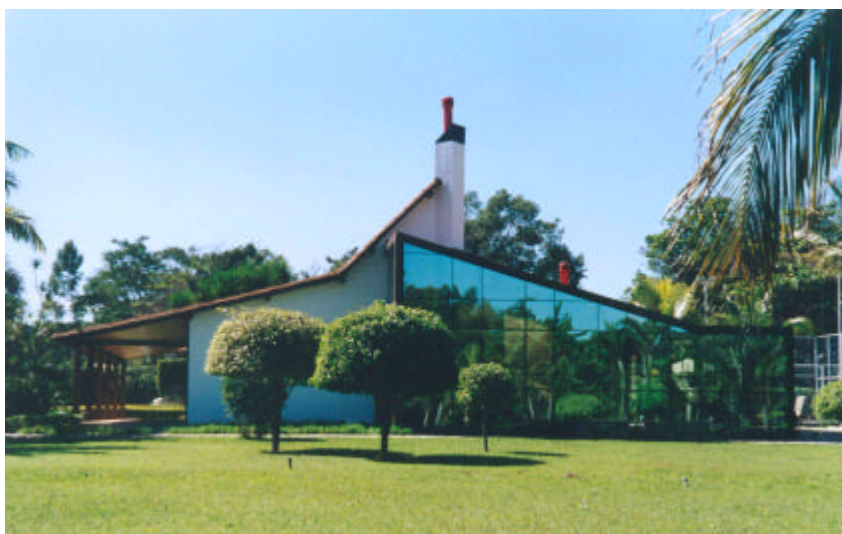
Figura 4.49– Vista frontal da ampliação. FONTE: Arquivo escritório de arquitetura.
