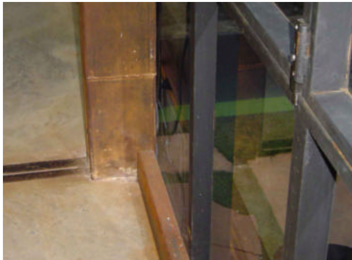
Figura A.17– Detalhe estrutura da pele de vidro em metalon. FONTE: Arquivo pessoal.
