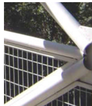
(c) Det. nó contraventamento vertical
