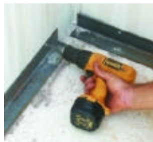
(d) Travamento dos painéis
