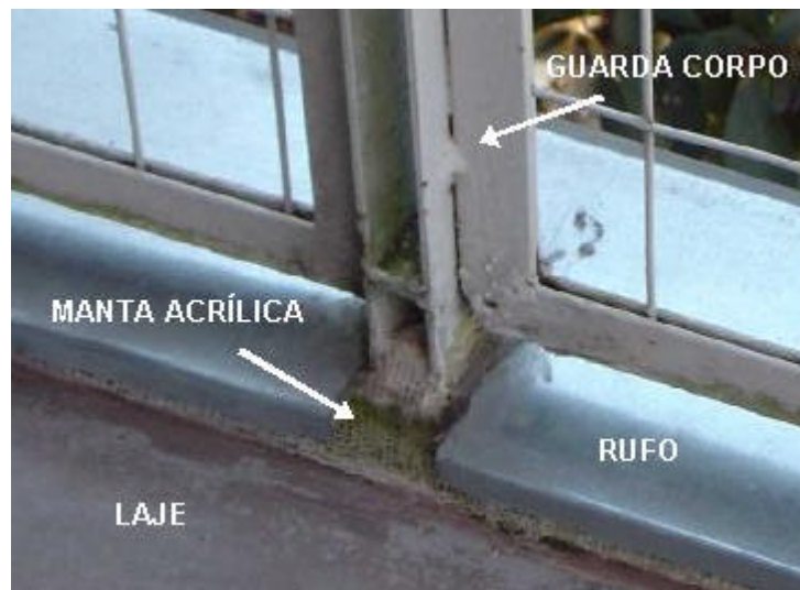
Figura 4.26 – Detalhe viga de borda da laje do terraço. FONTE: Arquivo pessoal
