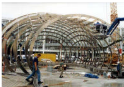
(e) Montagem da estrutura.
