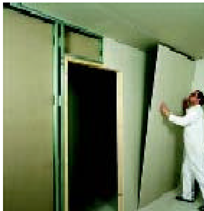
Figura 3.25 – Montagem do drywall – FONTE: Disponível em: < http://www.bpbplaco.com.br/imprensa_imagens.php?id=7 > Acesso em jun. 2005.
