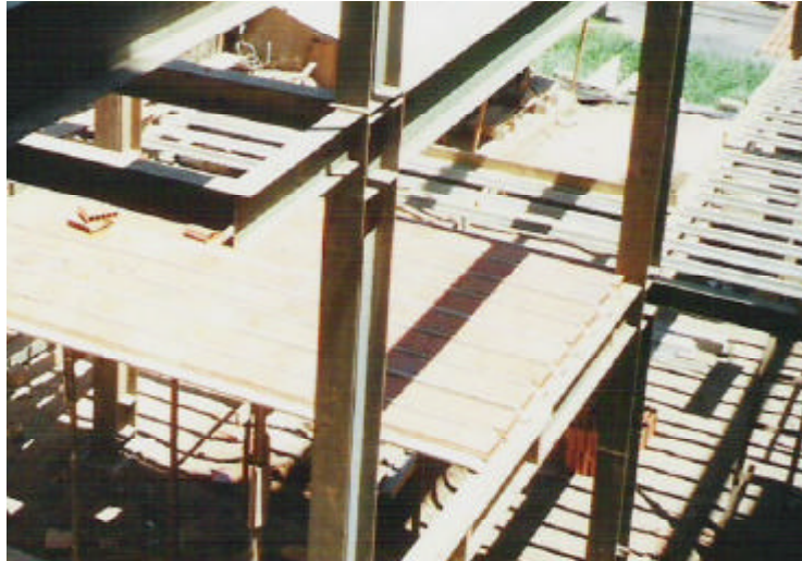
Figura 4.33 – Montagem das lajes pré-fabricadas.
