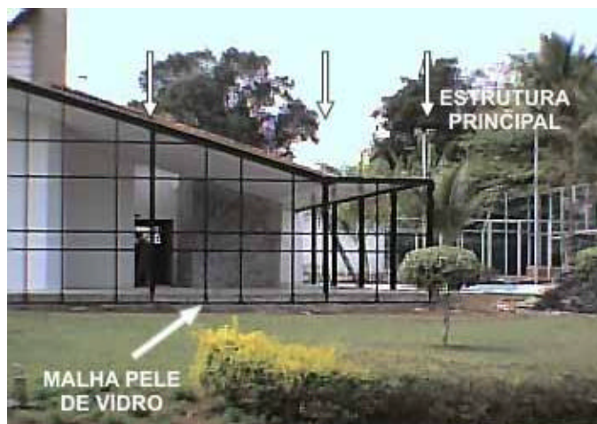
Figura 4.55– Vista parcial da estrutura montada. FONTE: Arquivo escritório arquitetura.
