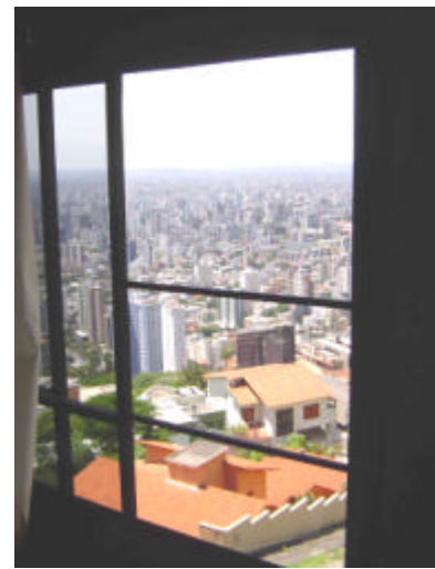
(b) Janela mezanino: barras de guarda-corpo
