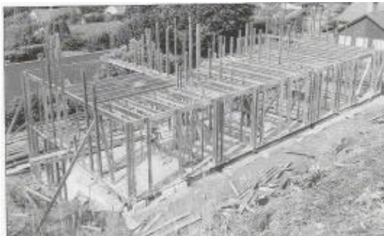
(a) Estrutura com elementos isolados: 'stick-build'
