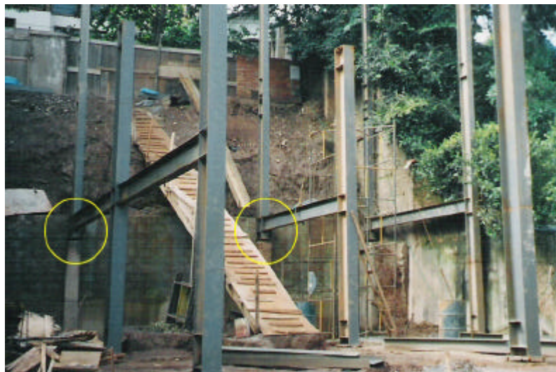
Figura 4.38 – Pilares metálicos descarregando sobre muro de arrimo. FONTE: Arquivo do arquiteto.
