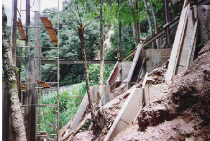
Figura 4.10 –Fundação: tubulões, blocos e cintamentos em concreto. FONTE: Arquivo do construtor
