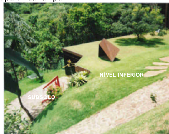
(c) Vista externa subsolo.
