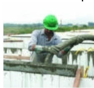
(e) Concretagem das paredes
