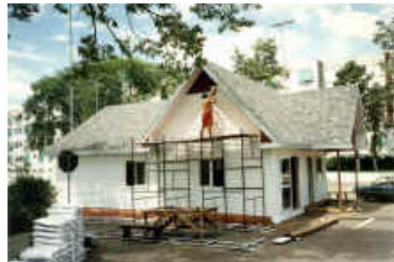
(b) Execução revestimento externo
