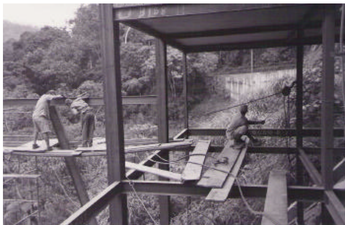
Figura 4.16 – Posicionamento do pilar inclinado com utilização de tifer. FONTE: Arquivo do construtor
