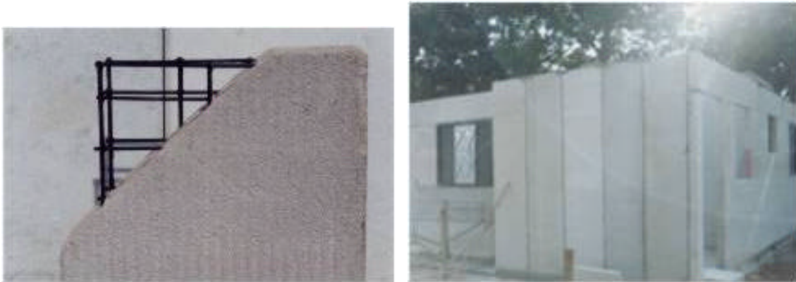
(a) Detalhe painel concreto celular autoclavado
