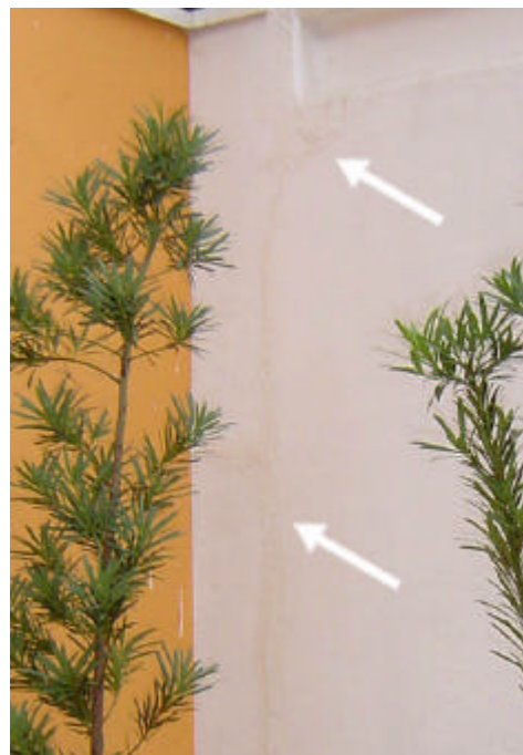
Figura 4.44 – Recuperação de fissura com mastique. FONTE: Arquivo pessoal.
