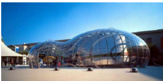
(a) Vista lateral da edificação.
