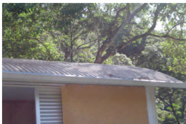
Figura 4.12– Visualização externa da cobertura em telha metálica simples. FONTE: Arquivo pessoal
