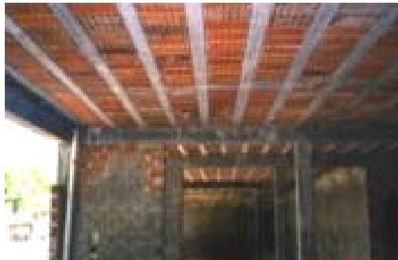
Figura 3.29 – Laje em vigotas de concreto e tijolos cerâmicos. FONTE: Arquivo pessoal.
