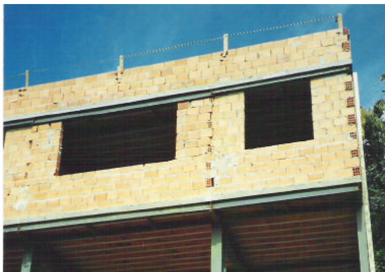
Figura 4.32 – Execução de fechamento em alvenaria. FONTE: Arquivo do arquiteto.
