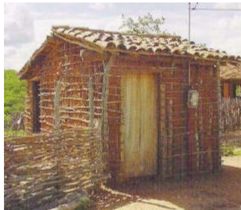
Figura 3.2– Construção em taipa-de-mão. FONTE: Encarte divulgação Eletrobrás.
