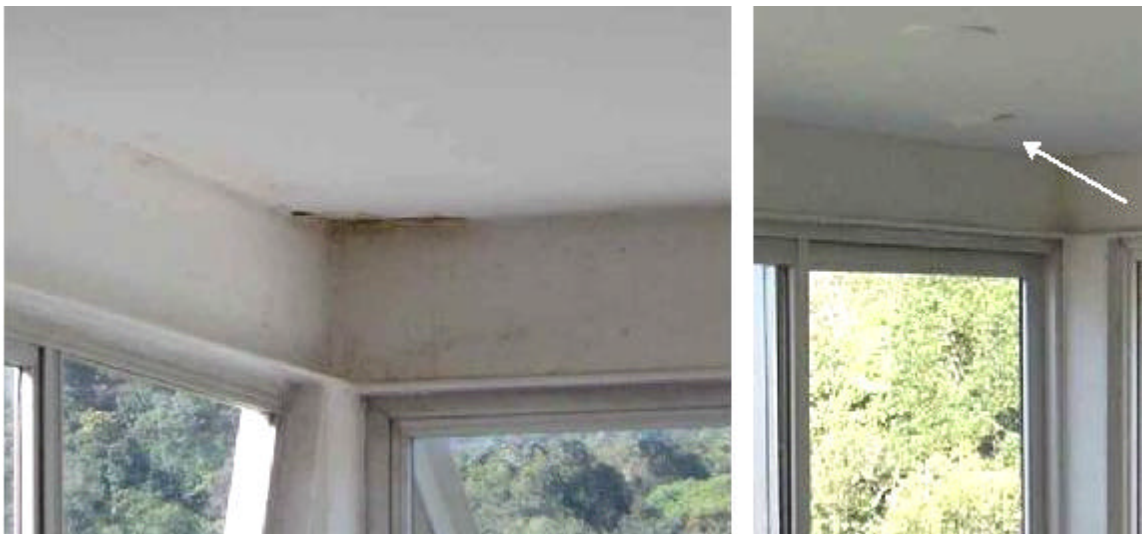
(b) Infiltração sala canto direito: descascamento do forro
