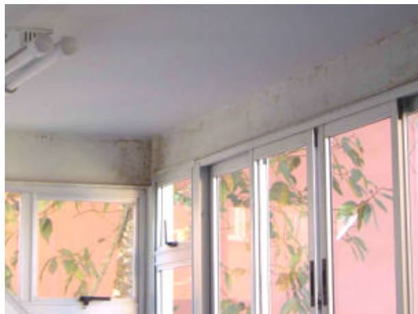
Figura 4.19 – Lavanderia: vigas com processo corrosivo relacionado à ausência de fundo em zarcão.
