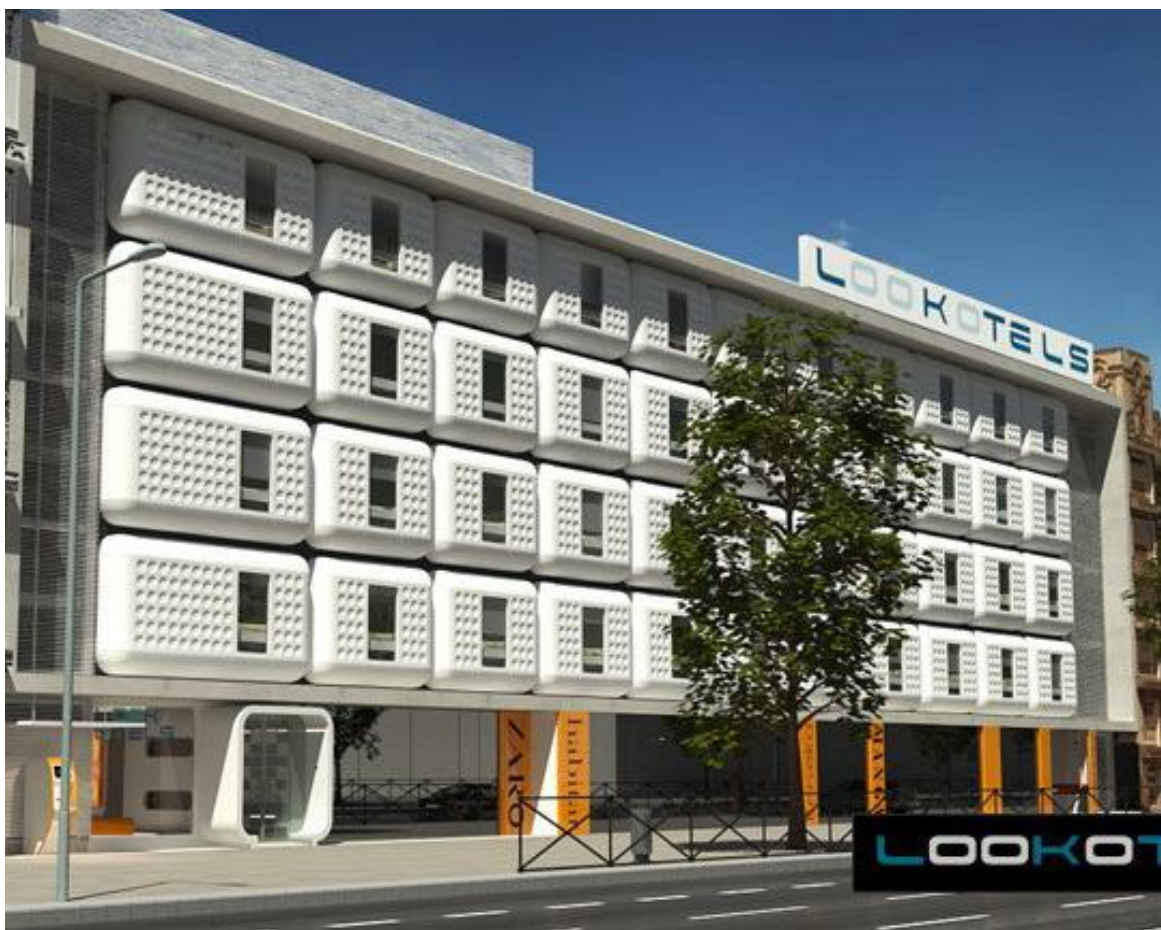
Figura 6.10 - Fachada do Lookotel composta pelos módulos tridimensionais.
