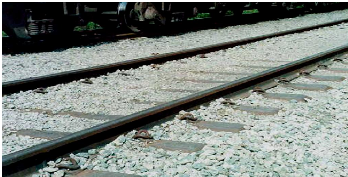
Figura 2.42 – Utilização da escória de aciaria em lastros ferroviários. (CST apud ROSSI, 2003).
