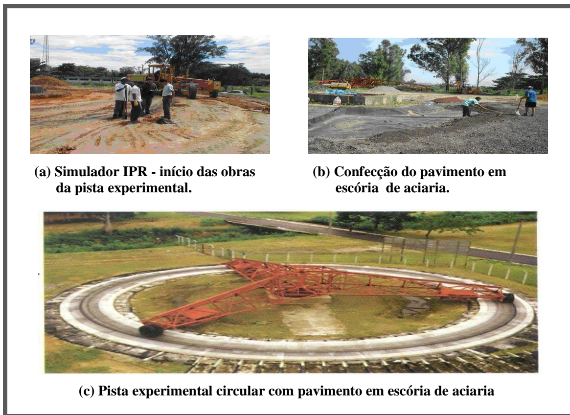
Figura 2.43 (a), (b) e (c) - Pista experimental circular em escória de aciaria (DNIT, 1980).
