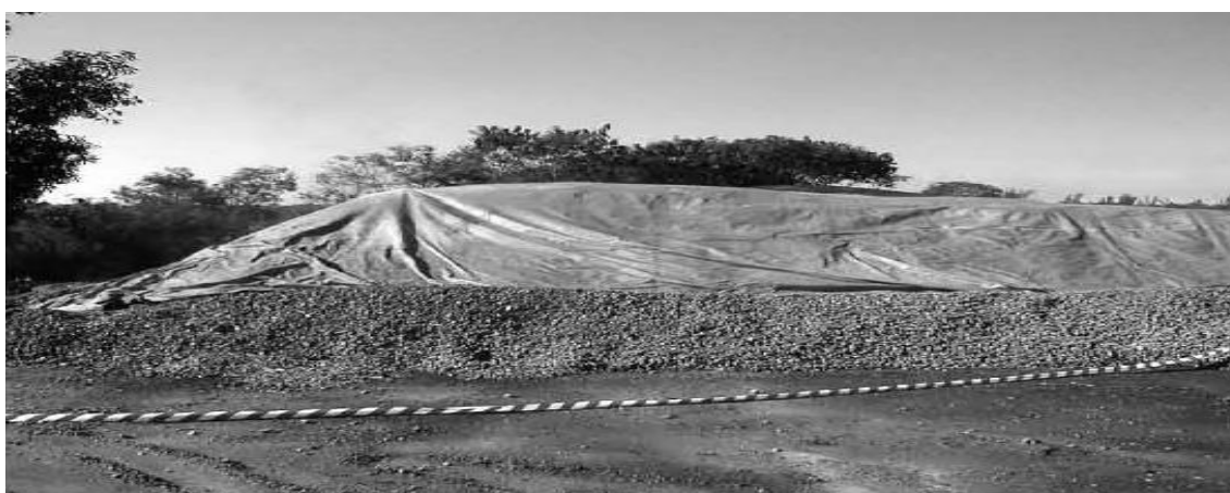
Figura 2.29 – Cura da escória de aciaria por injeção de vapor d'água (ABM, 2004).
