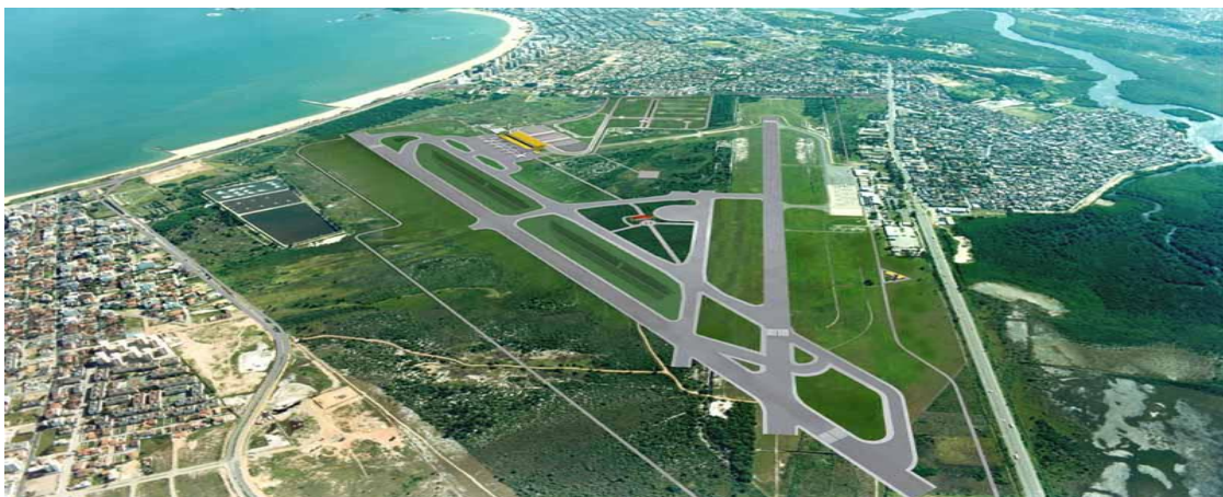
Figura 2.39 – Vista aérea da pista do aeroporto de Vitória ES - Camada de base em escória de aciaria (PORTAL DO GOVERNO ES, 2010).
