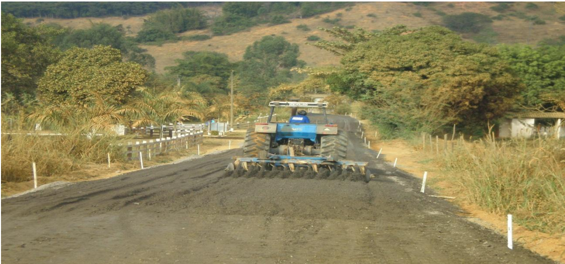
Figura 1.1 – Rodovia MG-232 – Confeção da camada de base em escória de aciaria - Trecho: Mesquita - Santana do Paraíso - Estaca 46 (DER/MG, 2006).
