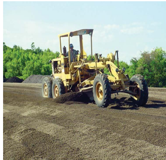
Figura 2.35 – Cura acelerada - aeração (ARCELORMITTAL, 2008).
