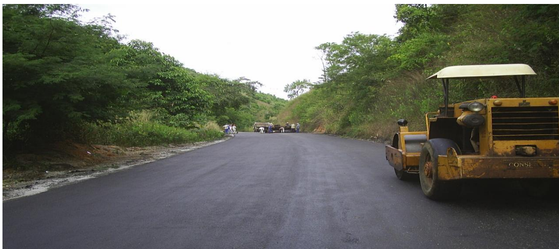
Figura 5.1 – Revestimento em PMF - Rodovia MG 232 – Mesquita/Santana do Paraíso (ACERVO TÉCNICO 40ª CRG - DER/MG, 2007).
