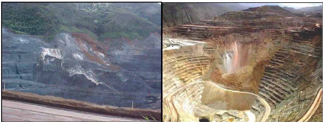
Figura 1.1 – Rupturas de taludes de mineração: Innocentini (2003); Huallanca (2004)
