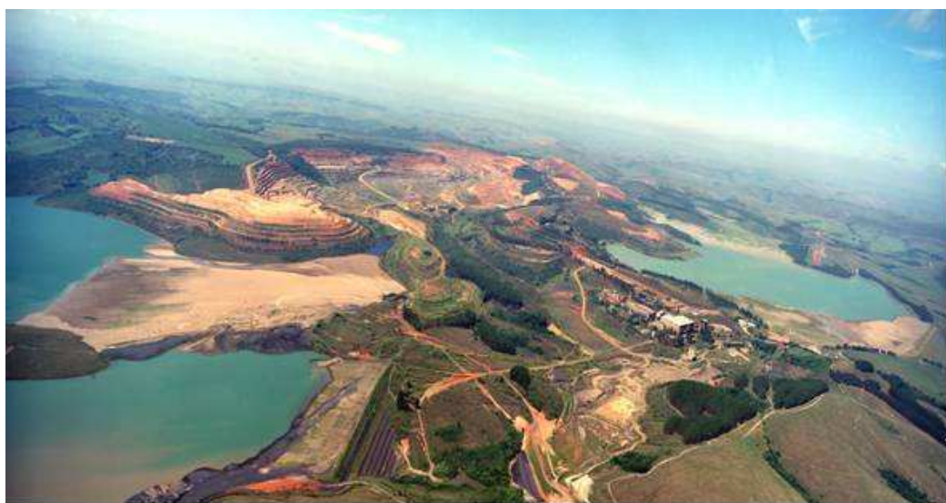
Figura 3.2 – Vista geral do Complexo Tapira.
