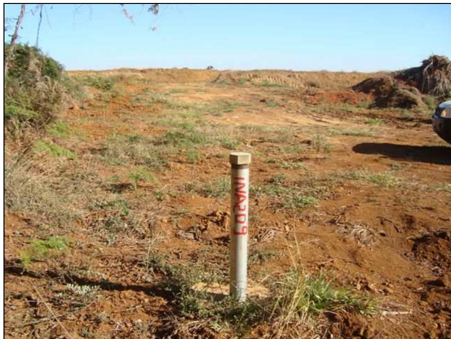
Figura 5.21 – Indicador de nível de água instalado nos taludes da Mina de Tapira
