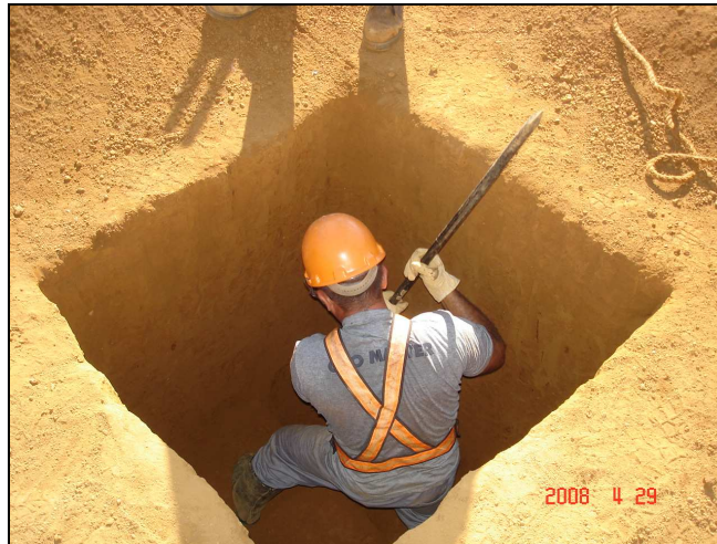
Figura 5.2 – Execução de poço de inspeção (PI - 101) na Mina de Tapira
