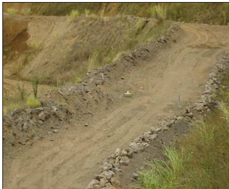
Figura 5.23 – Marco Superficial instalado nos taludes da Mina de Tapira.
