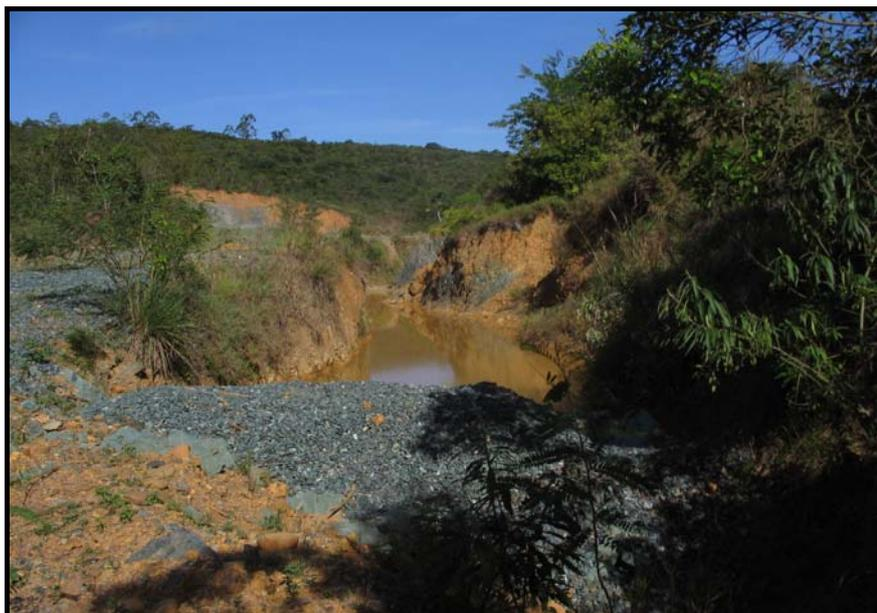
**Figura 5.2** - Foto mostrando a barragem de contenção de efluentes e materiais particulados oriundos da mina Francisco III.
