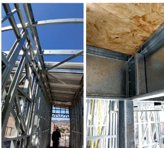
Figura 1.1 – Etapa da construção do Centro de saúde no bairro Coqueiros, em BH, com os PFF ainda expostos.
