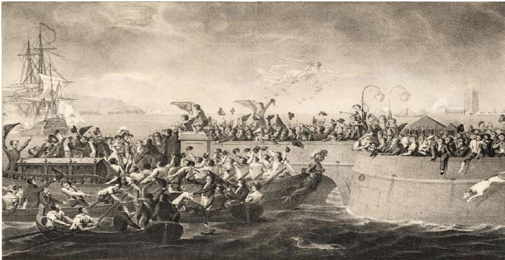
Figura 4: Desembarque do Augustíssimo Senhor D. Miguel no Caes de Belém, Mauricio José do Carmo Sendim. Domínio público, Palácio Nacional de Queluz
