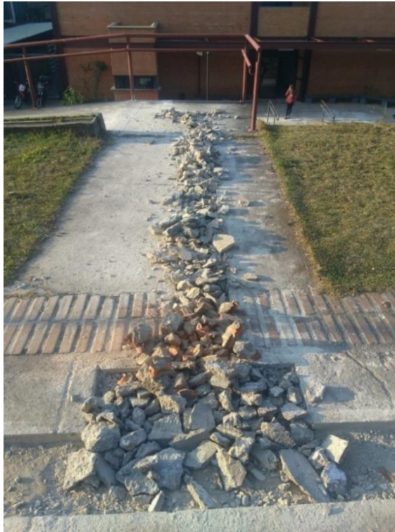
Figura 5 - Calçada de concreto demolida Campus Morro do Cruzeiro - UFOP.
