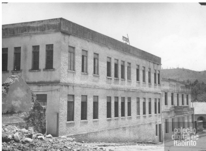
Fotografia. Fachada do Ginásio Guilherme Gonçalves. Década de 1950. Autor: s./r. Fonte: Coleção Itabirito Digital . Referência do desenho da Figura 2.
