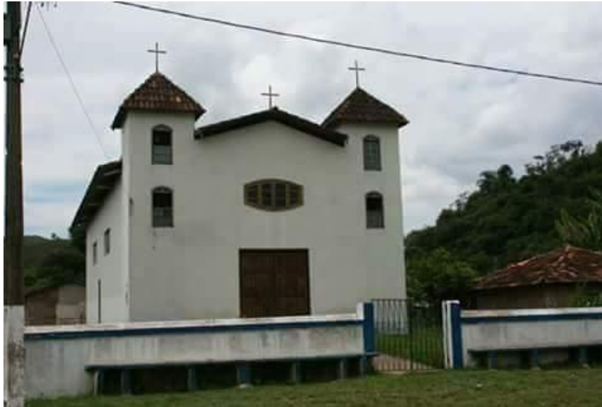
Figura 12 - Capela de Santo Antônio. Imagem cedida pela comunidade
