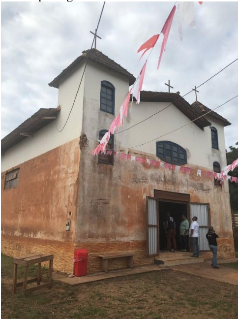
Figura 2 - Capela de Santa Antônio após passagem da lama. Junho/2018
