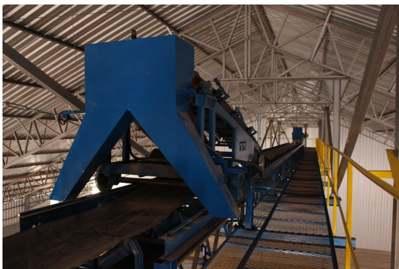
Figura 2.7: Tripper
