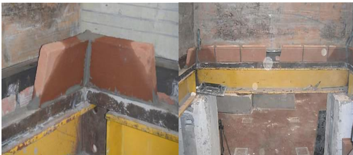
Figura 29: Junta com ângulo de 30° e primeira fiada de tijolos.
