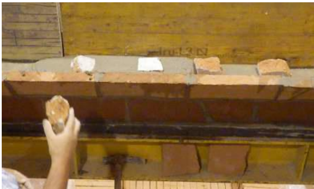
Figura 30: Assentamento de tijolos para execução da abóbada.
