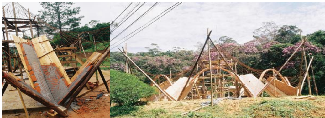
Figura 36: Execução abóbada, ferragem e forma de madeira para colocação de tijolos.
