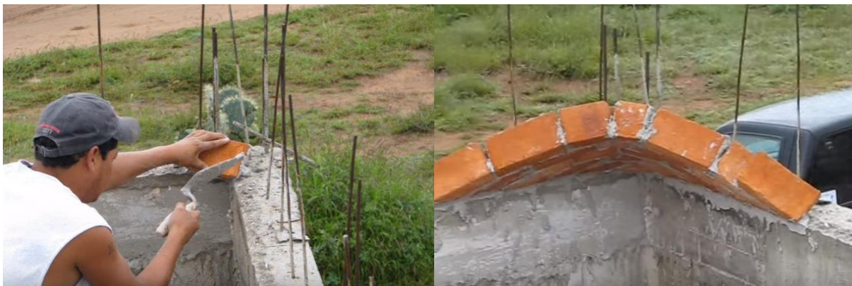
Figura 32 : Execução Abóbada Mexicana, primeiro tijolo e primeiras fiadas.
