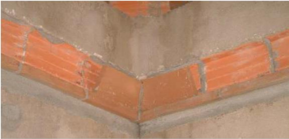
Figura 27: Vista interna abobadilha
