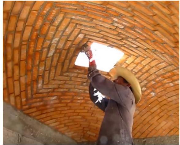
Figura 33: Execução abóbada mexicana, começa nos cantos até chegar ao centro.
