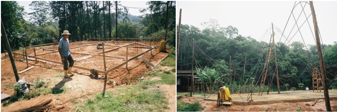
Figura 35: Execução abóbada, preparação do terreno e sapatas para os pilares.
