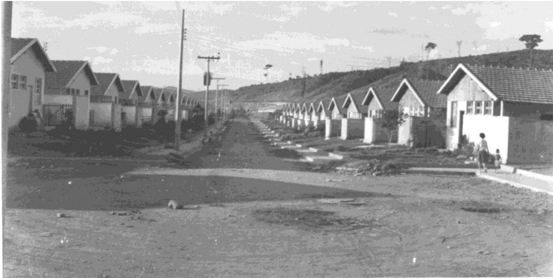
FIG. 14: Construção do bairro Bom Retiro em Ipatinga (ACECIVA).
