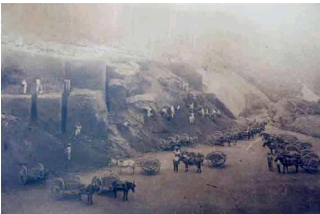
FIG. 8: Implantação de trecho da EFVM, Coronel Fabriciano MG (ACECIVA).
