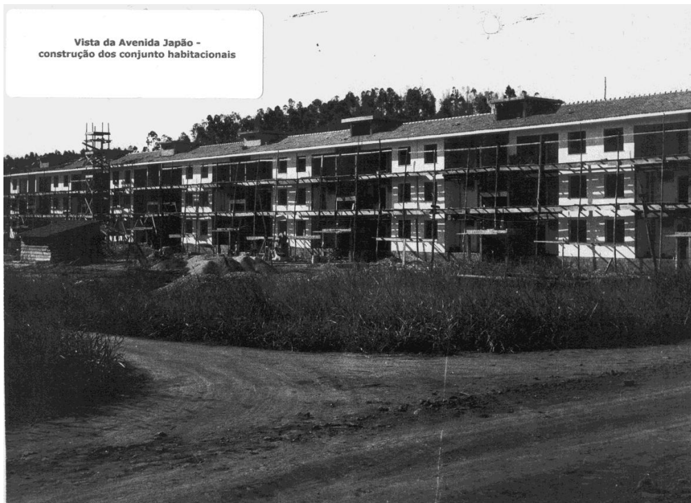
FIG. 13: Construção do bairro Carirú em Ipatinga (ACECIVA)
