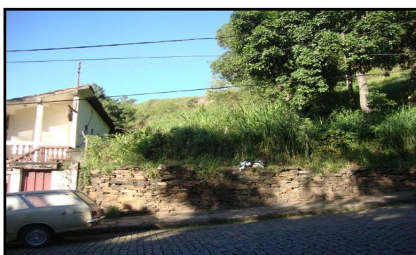
Local proposto para instalar um plano inclinado no Morro da Forca/Ouro Preto
