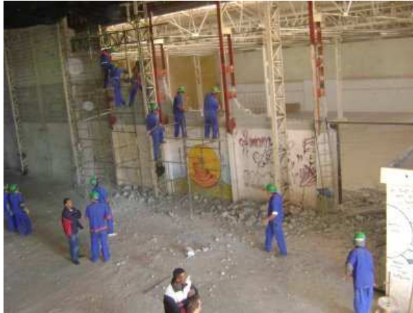
Figura 14 – Demolição Seletiva Fonte: Brava Companhia (2009)
