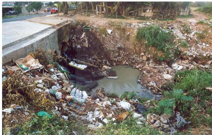
Figura 9 – Obstrução de córrego Fonte: http://www.ietsp.com.br (2010)
