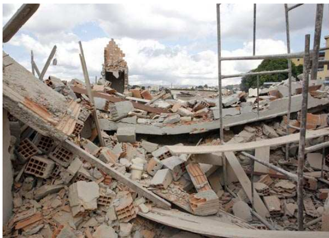
Figura 1 - Resíduos sólidos de uma demolição
