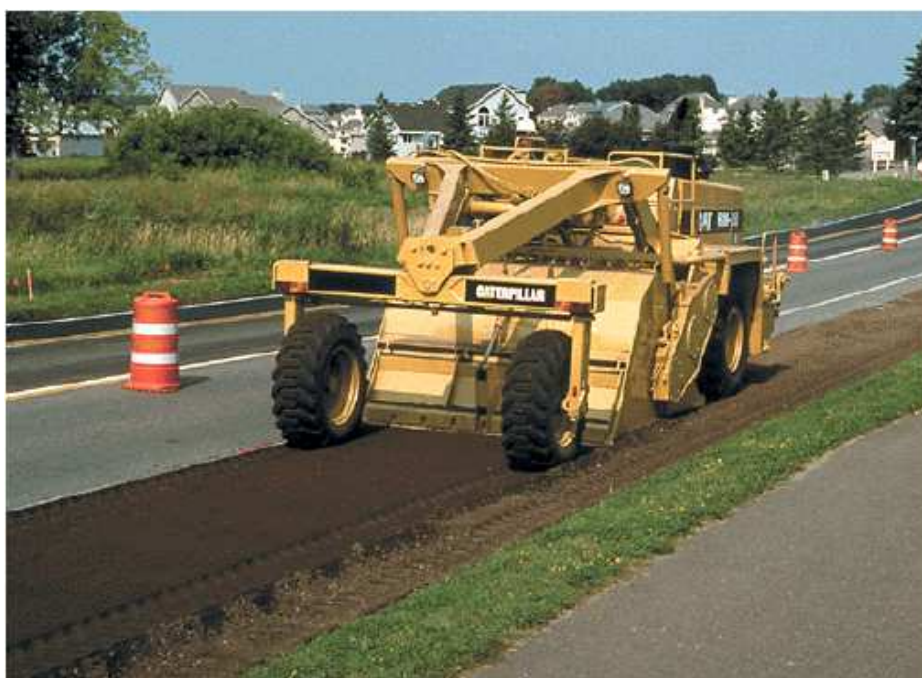
Figura 21 – Execução de sub-base de via utilizando resíduos Fonte: http://www.pavisan.com.br/info/Controles (2010)
