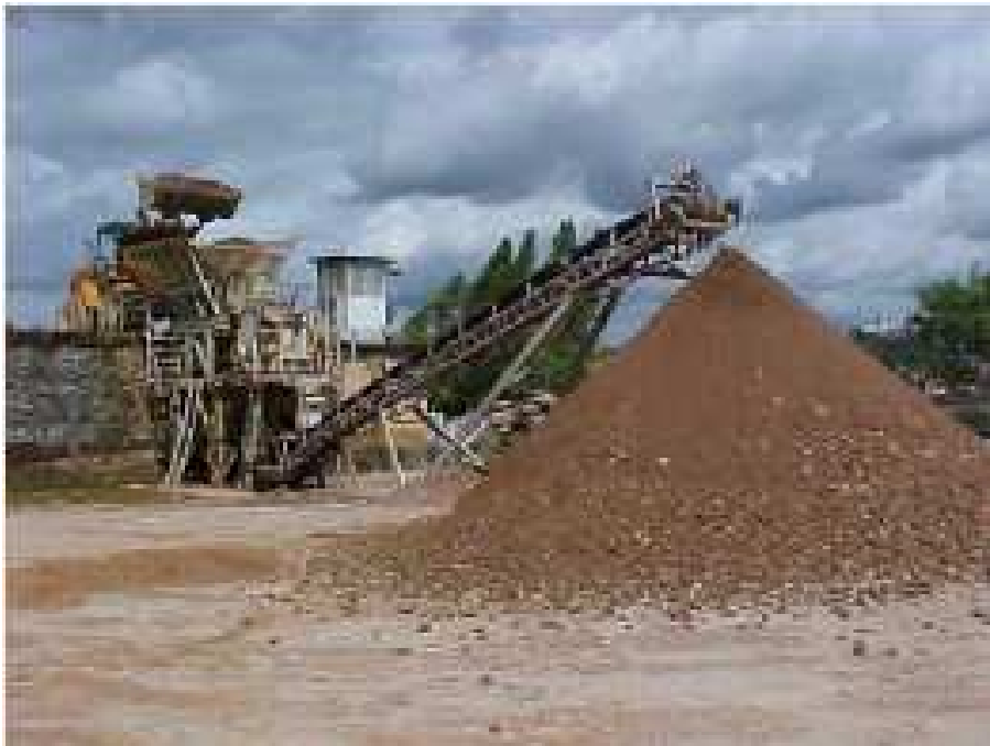
Figura 20 – Estação de Reciclagem de entulho em Belo Horizonte Fonte: autor da dissertação (2010)
