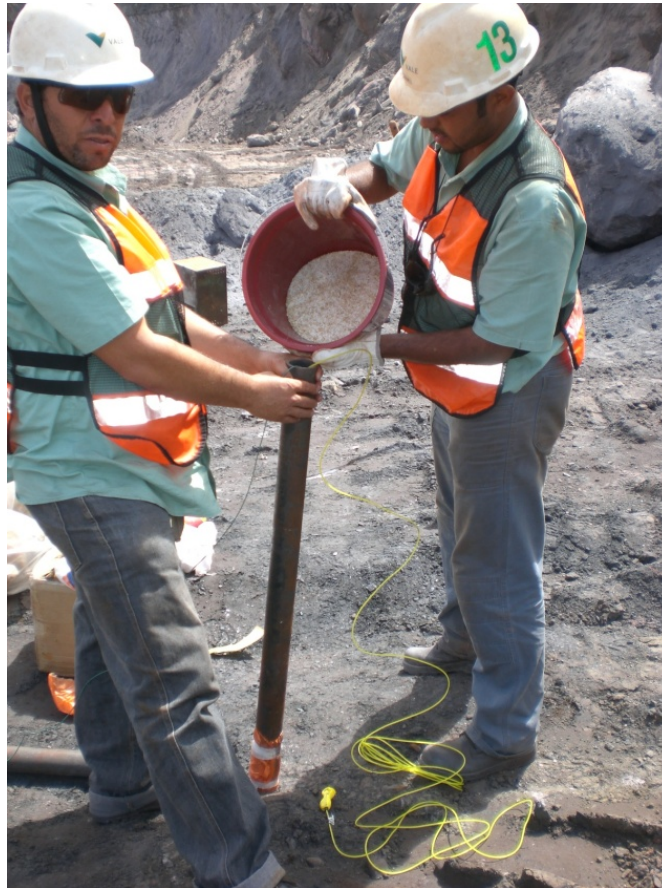
Figura 19: Carregamento da mistura em tubos de aços Schedule 80
