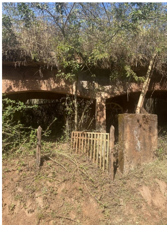
Imagem 5 - Ruínas em Bento Rodrigues, 15 de julho de 2022
