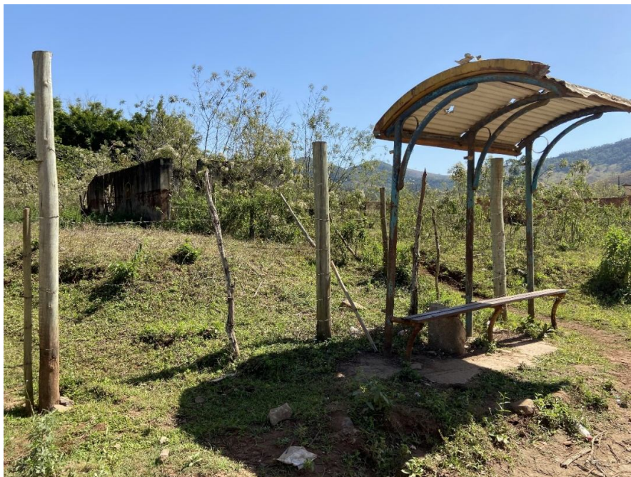
Imagem 23 - Ruínas em Paracatu de Baixo, 29 de julho de 2022
