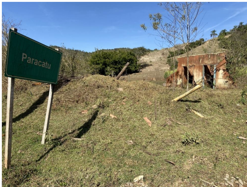
Imagem 19 - Ruínas em Paracatu de Baixo, 29 de julho de 2022
