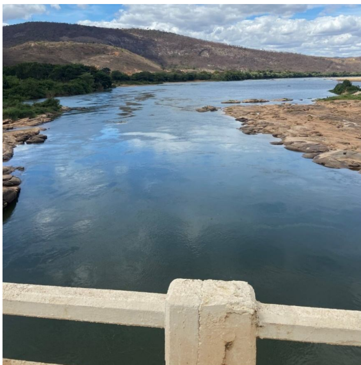
Imagem 42 – Rio Doce sob a ponte do município de Conselheiro Pena/MG, em 21 de agosto de 2021
