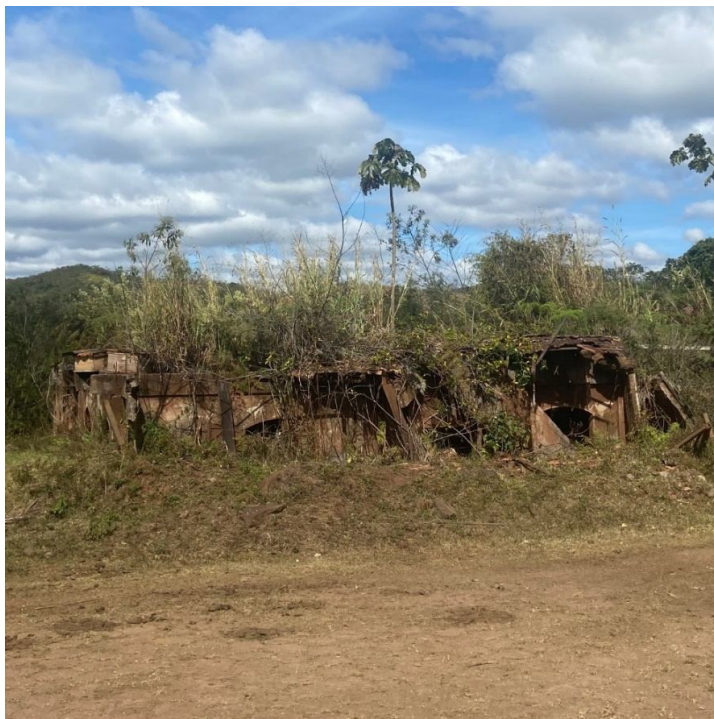
Imagem 4 - Ruínas em Bento Rodrigues, 15 de julho de 2022
