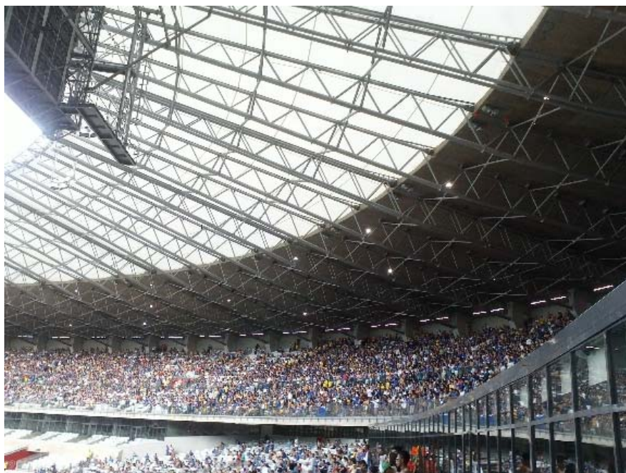
Figura 1 – Estrutura tubular da cobertura do Estádio Mineirão, Belo Horizonte. (Nunes, 2017).
