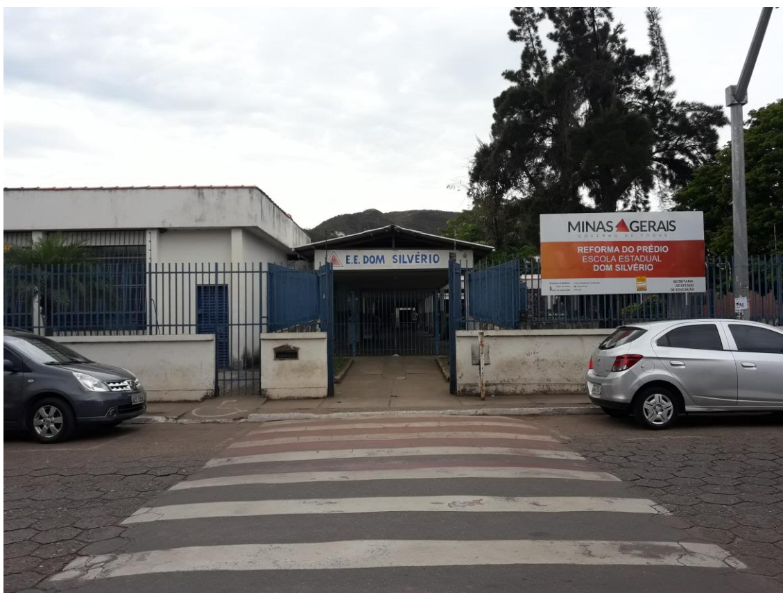
Figura 2 Fachada da E. E. Dom Silvério
